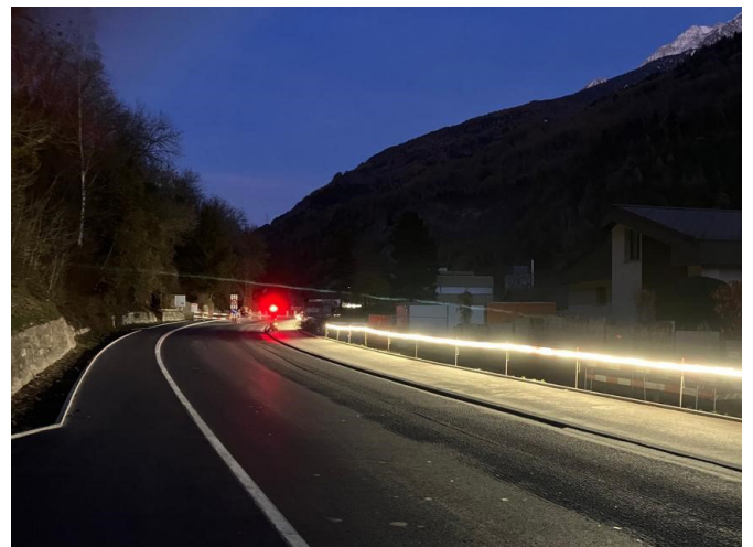
Chantier de Bitsch VS
